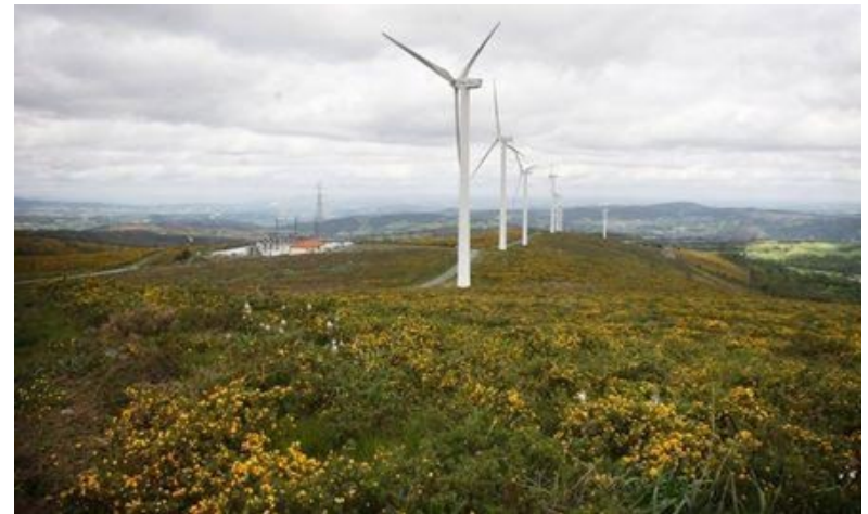
Hib. EO + FV portfolio Ávila FINERGE ( EO 70 MW p + FV 55 MW p )
